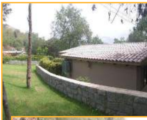
CONSTRUCCIÓN DE MURO DE CONTENCIÓN PARA CANALIZAR DESLIZAMIENTO DE LODOS EN ÉPOCA DE HUAICOS EN ÁREAS VERDES
