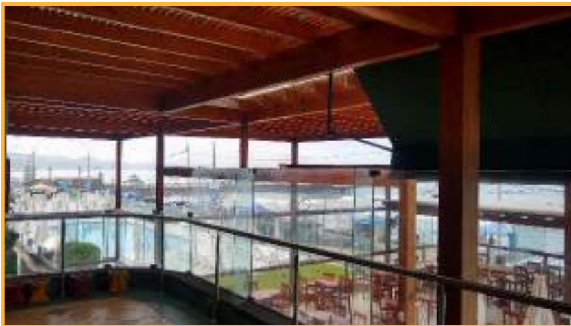
INSTALACIÓN DE BARANDAS PROTECTORAS DE ACUERDO CON LA NORMATIVA DE INDECI
