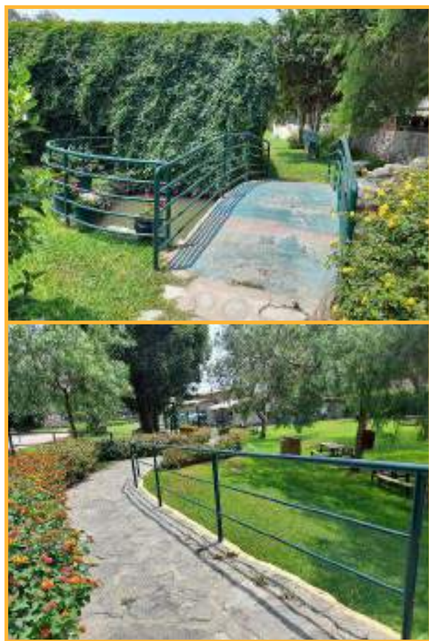
INSTALACIÓN DE BARANDAS Y PASAMANOS DE FIERRO EN LA SEDE
