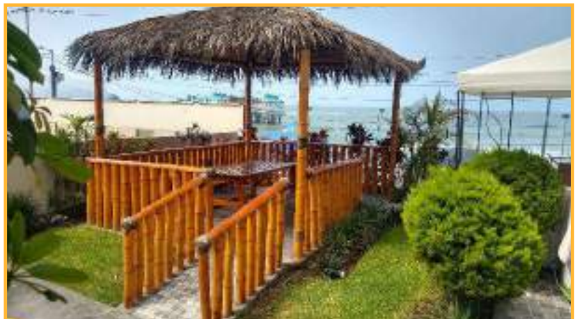
REMODELACIÓN Y REFORZAMIENTO DE ZONA DE PARRILLA Y REMOZAMIENTO DE JARDINES
