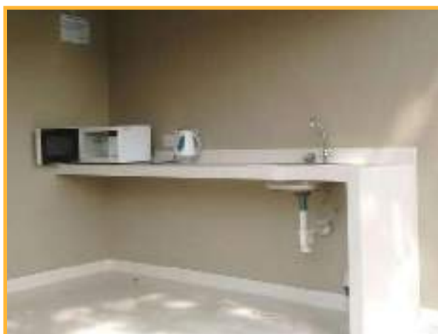
INSTALACIÓN DE ÁREA DE COCINA EN LA ZONA DE CAMPAMENTO “LOS PAPIROS”
